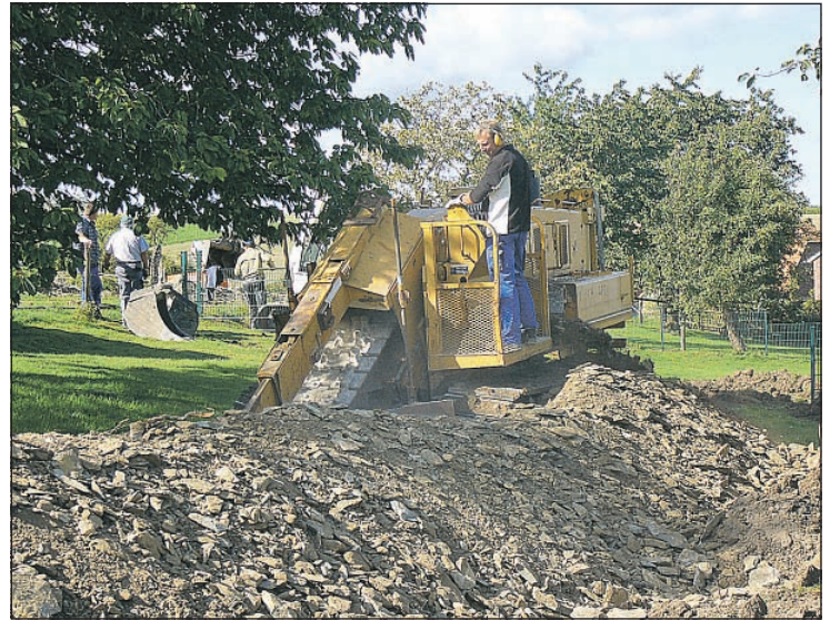
Bei solchen Bildern treten vielen Gartenbesitzern die Tränen in die Augen. Hier entsteht in Altenmellrich das Nahwärmenetz. Die Erdarbeiten haben den Anwohnern einiges abverlangt.
