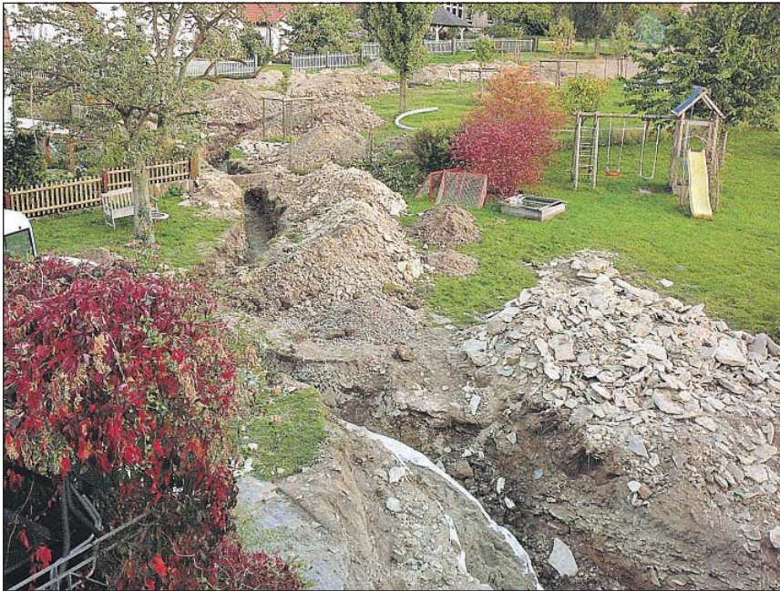
Bei solchen Bildern treten vielen Gartenbesitzern die Tränen in die Augen. Hier entsteht in Altenmellrich das Nahwärmenetz. Die Erdarbeiten haben den Anwohnern einiges abverlangt.
